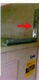
ある程度の地震の揺れなら、アンカーボルトの固定だけで十分ですが、近年、南海地震の発生で激しい揺れが予想されている中、弊社では、念には念を入れて、との思いから、左の画像のようにL型の金属金具を用い、本体上部を家の壁面へ固定する措置をご提案しています。
